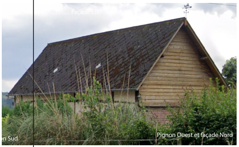
Façade Nord et pignon Est
